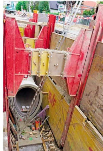
Das TWF Grabenverbausystem Doppelgleitschiene Standard ermöglicht Einbautiefen bis 6,20 m. Einer der Vorteile des Systems: für die Verlegung der Kanalleitung mit Ei-Profil im Abschnitt Reichenauer Straße verbleibt ausreichend lichte Höhe unterhalb des Querträgers.
