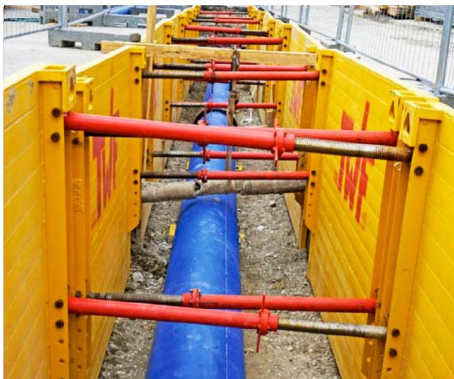
Der Leichtverbaue Type 100 ist bei standfesten Böden eine ideale Lösung für Einbautiefen bis 3 m bzw. ist das Verbausystem auch aufstockbar.
