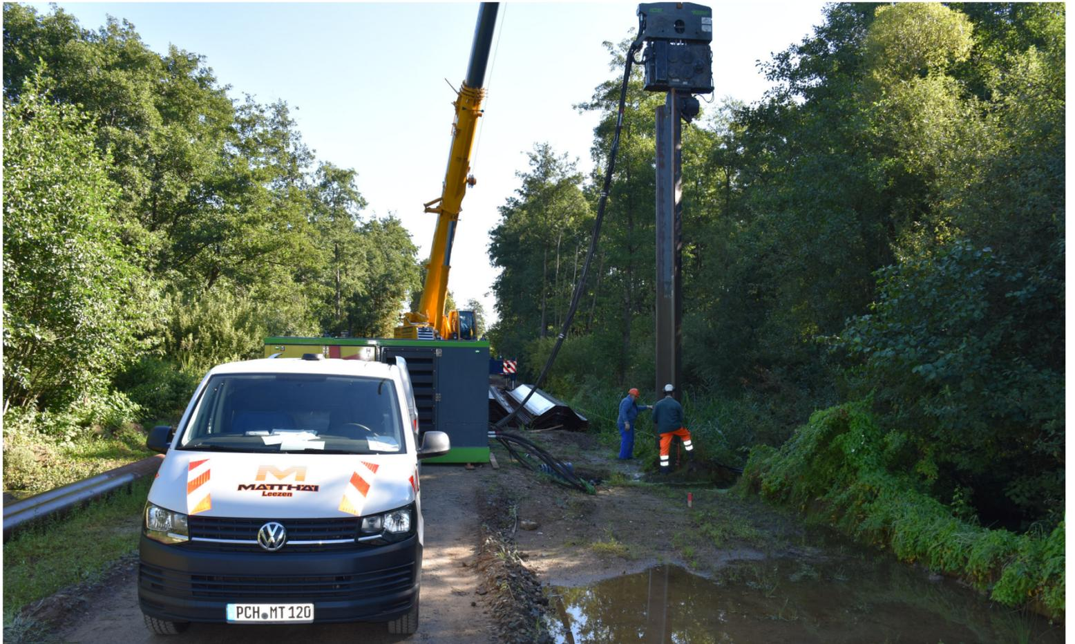
Die Vibrationsramme, derzeit an der Kreisstraße 30 bei Cramon im Einsatz, hängt an einem Kran und ist fünf Tonnen schwer.
