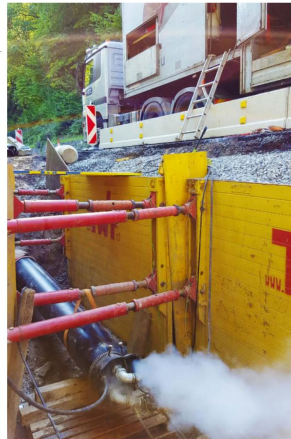
Zum Rückverformen wird der Close-Fit Liner mit Wasserdampf unter Druck gesetzt. Dank des Memory-Effekts springt er in seine ursprüngliche, kreisrunde Form zurück.
