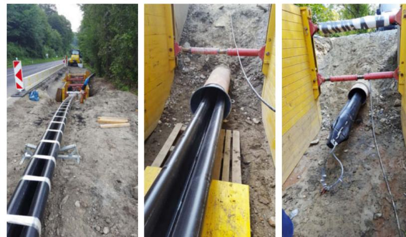
Der mit einem Ziehkopf ausgestattete Rohrstrang wird mittels Seilwinde ins Altrrohr eingezogen.
